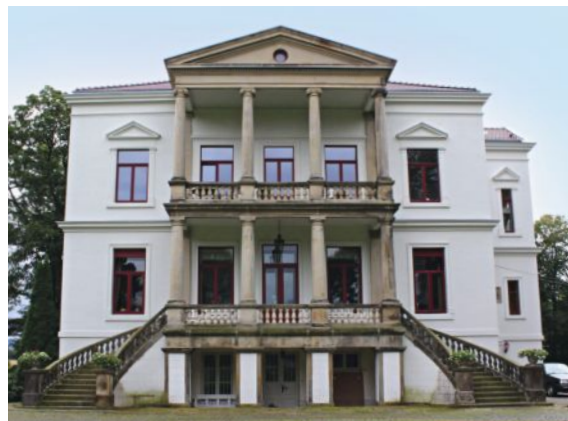
3+4 Vorher/nachher. Die Fassade dieses Mehrfamilienhauses wurde rekonstruiert. Für die Risalit-Einfassung erfolgten Abform- und Gussarbeiten mit Romankalkmörtel.
