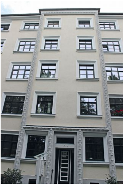
3+4 Vorher/nachher. Die Fassade dieses Mehrfamilienhauses wurde rekonstruiert. Für die Risalit-Einfassung erfolgten Abform- und Gussarbeiten mit Romankalkmörtel.
